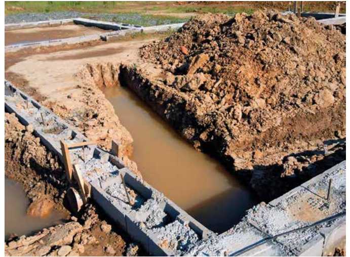
Příklady podloží nevhodného pro zasakování srážkových vod
