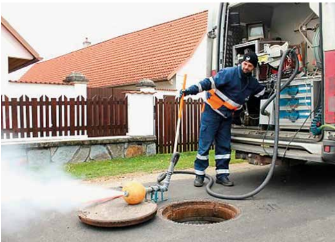
Prověřování kanalizačních přípojek generátorem kouře
