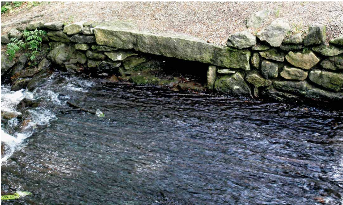
Kaplický potok (23.1) obnovený bezpečnostní přeliv Jezírka ústí obtokové stoky
