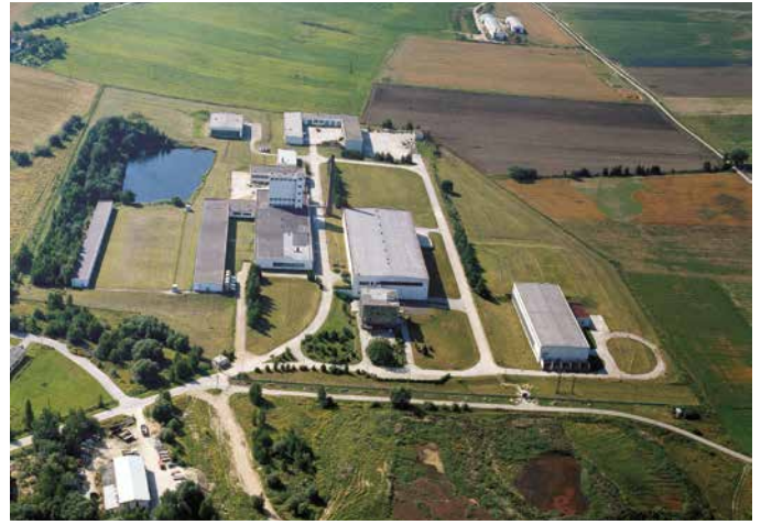
Úpravna vody Plav
