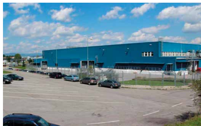
Obr. 4. Totálně odvodněné plochy hal a parkovišť se ohřívají až na 60 °C, při dešti z nich voda rychle odtéká do kanalizace, dešťové odlehčovače se vyplachují do toků a zatěžují je nevyčištěnou splaškovou vodou.
