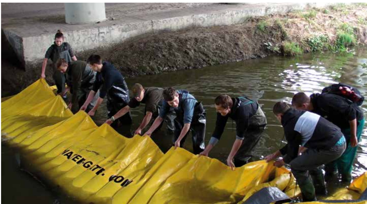
Obr. 4. Stavíme hradící stěnu ve vodním toku
