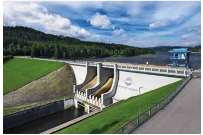
Obr. 7. Hráz vodní nádrže Lipno I
