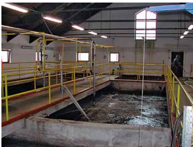
Obr. 6, 7. ČOV Suchdol nad Lužnicí vybudovaná v letech 1994–1995
