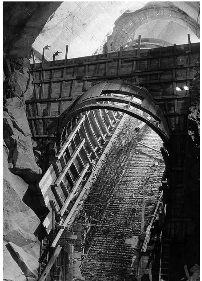
Obr. 5. Šikmý tunel do budoucího prostoru elektrárny
