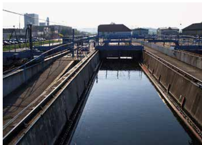
Obr. 4, 5. ČOV Horažďovice vybudovaná v letech 1993–1994
