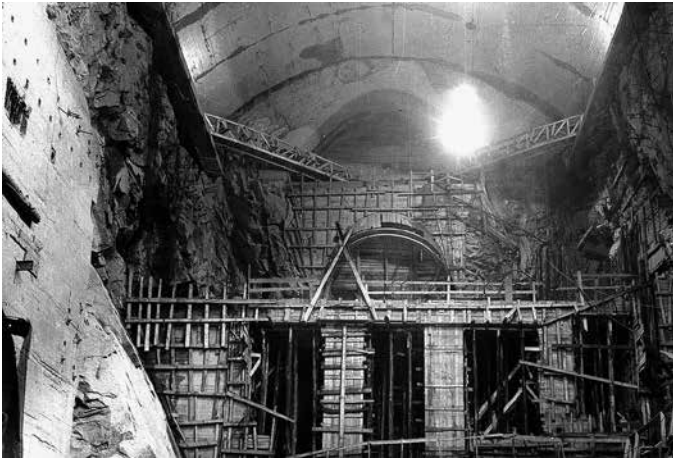
Obr. 6. Výlom jádra v podzemní hydrocentrále
