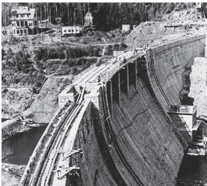
Bednění mostovky a koruny hráze rok 1938 (archív Povodí Vltavy, státní podnik)
