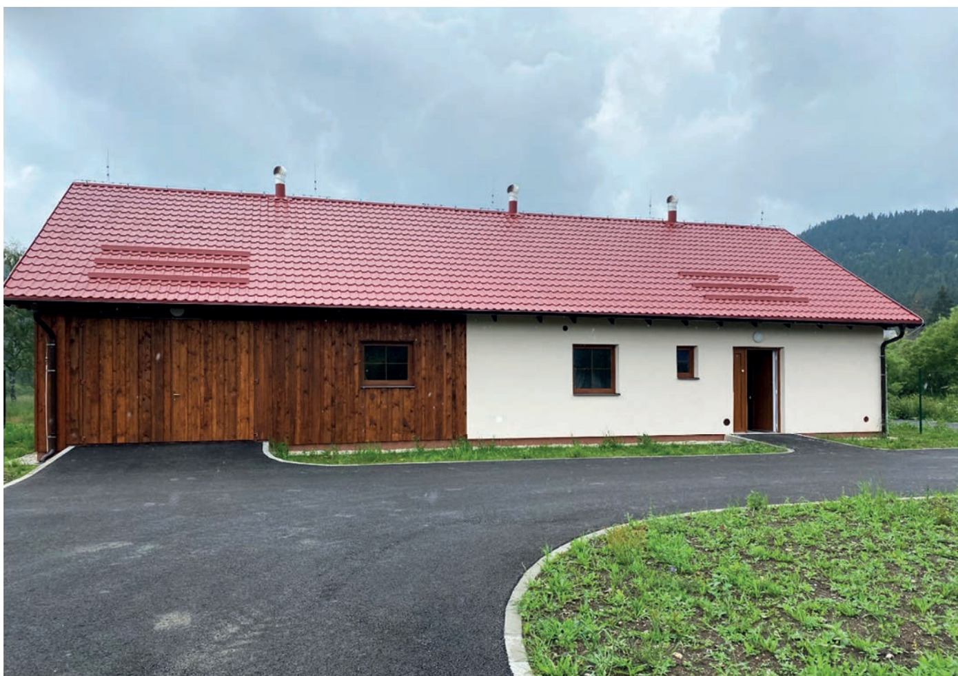
Obr. 1. Čistírna odpadních vod v Borové Ladě. Zdroj: Archiv Čevak a. s.
