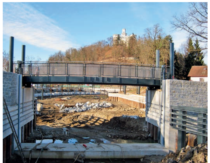
Obr. 5. Stavba přístavu Hluboká nad Vltavou. Zdroj: Archiv autora
