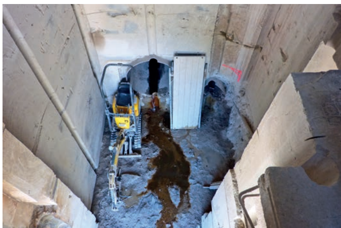
Pohled do vybourané šachty ve strojovně (archiv Povodí Vltavy, státní podnik)
