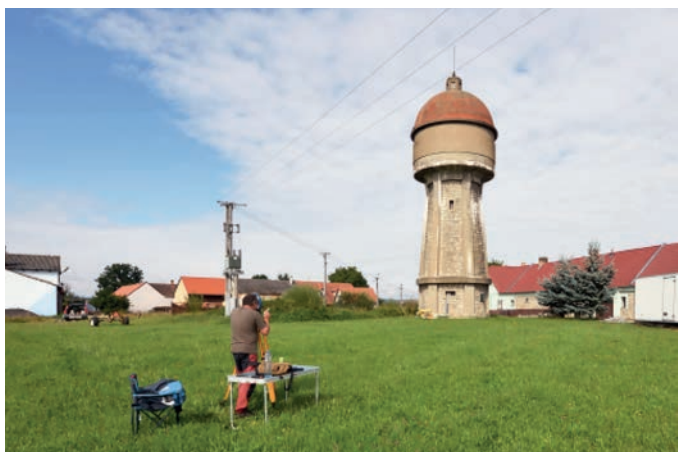
Obr. 1. Zaměřování věžového vodojemu v Něchově. Zdroj: Archiv projektu, 2020
