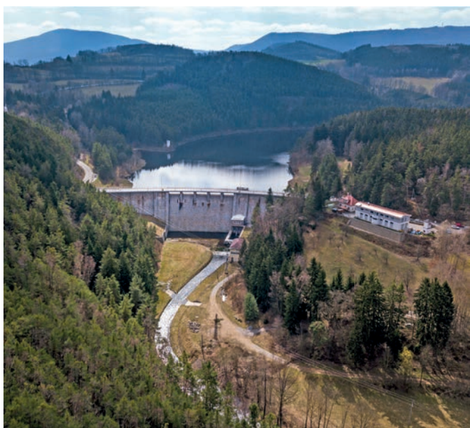
Celkový pohled na areál VD Husinec (archiv Povodí Vltavy, státní podnik)
