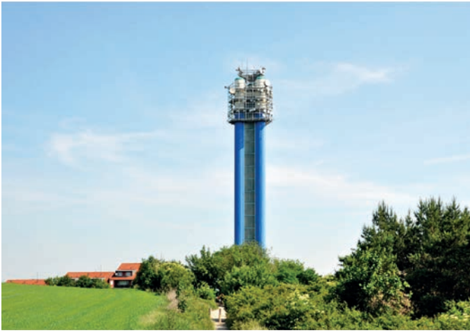
Obr. 3. Vyrovnávací věž v Praze-Radlicích slouží k tlumení vodních rázů v potrubí a bývá označována jako vodárenská věž. Mezi věžové vodojemy ji v rámci našeho projektu však neřadíme. Zdroj: Archiv projektu, 2011
