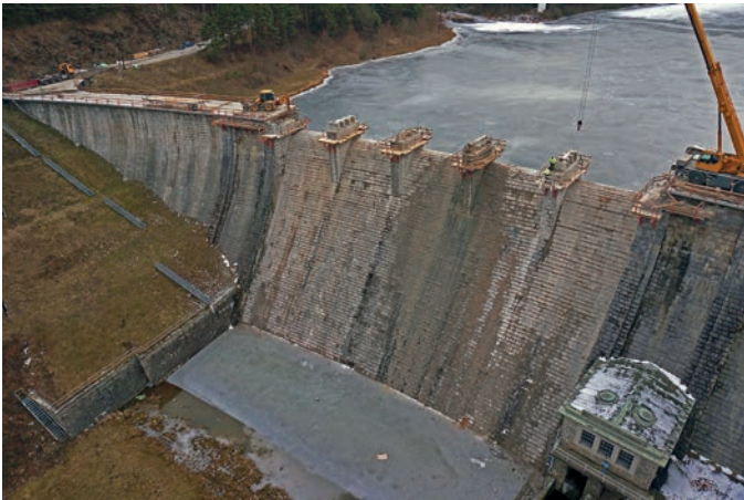
Demolice původních pilířů mostovky (archiv Povodí Vltavy, státní podnik)
