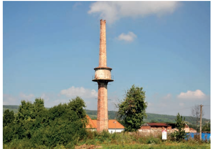
Obr. 5. Komínový vodojem Vilémov-Zahořany postavený kolem roku 1920. Zdroj: Archiv projektu, 2014
