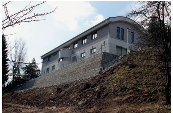
Dokončená gabionová zeď, jako zpevnění svahu (archiv Povodí Vltavy, státní podnik)
