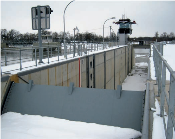
Obr. 2. Stavba plavební komory České Vrbné. Zdroj: Archiv autora
