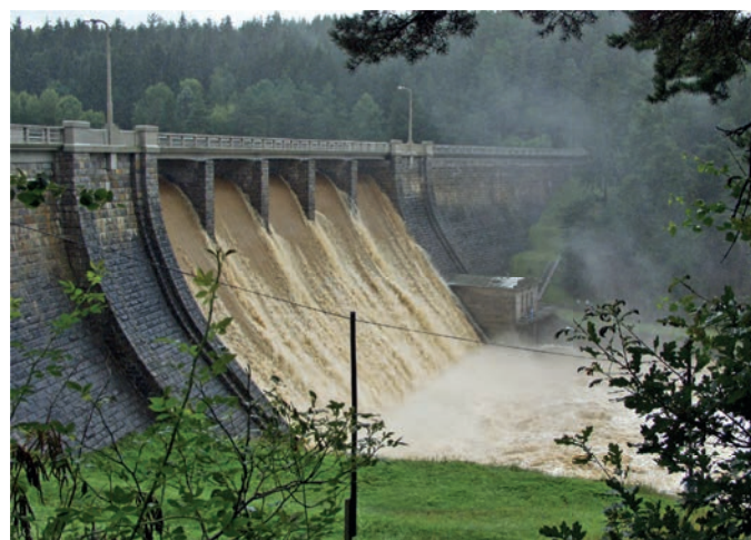
Přeliv VD Husinec při kulminaci povodně 2002 (archiv Povodí Vltavy, státní podnik)
