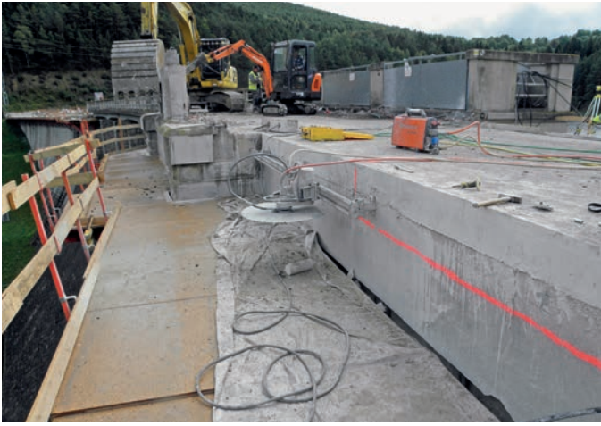
Nařezávání koruny hráze před jejím odbouráním (archiv Povodí Vltavy, státní podnik)
