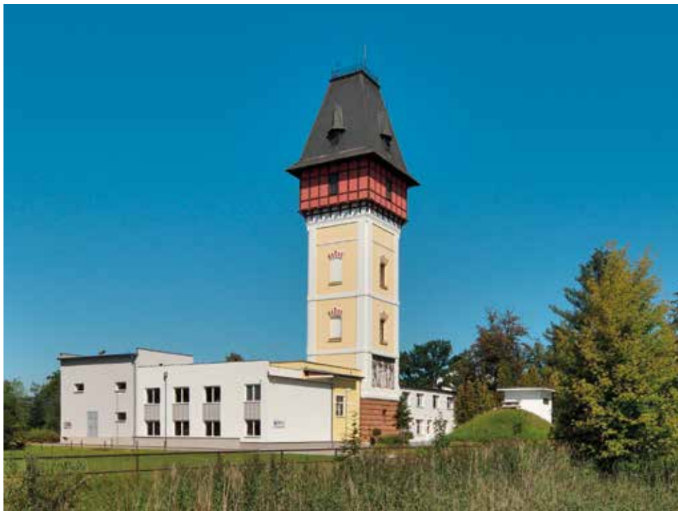
Obr. 5. Věžový vodojem v Českých Budějovicích
