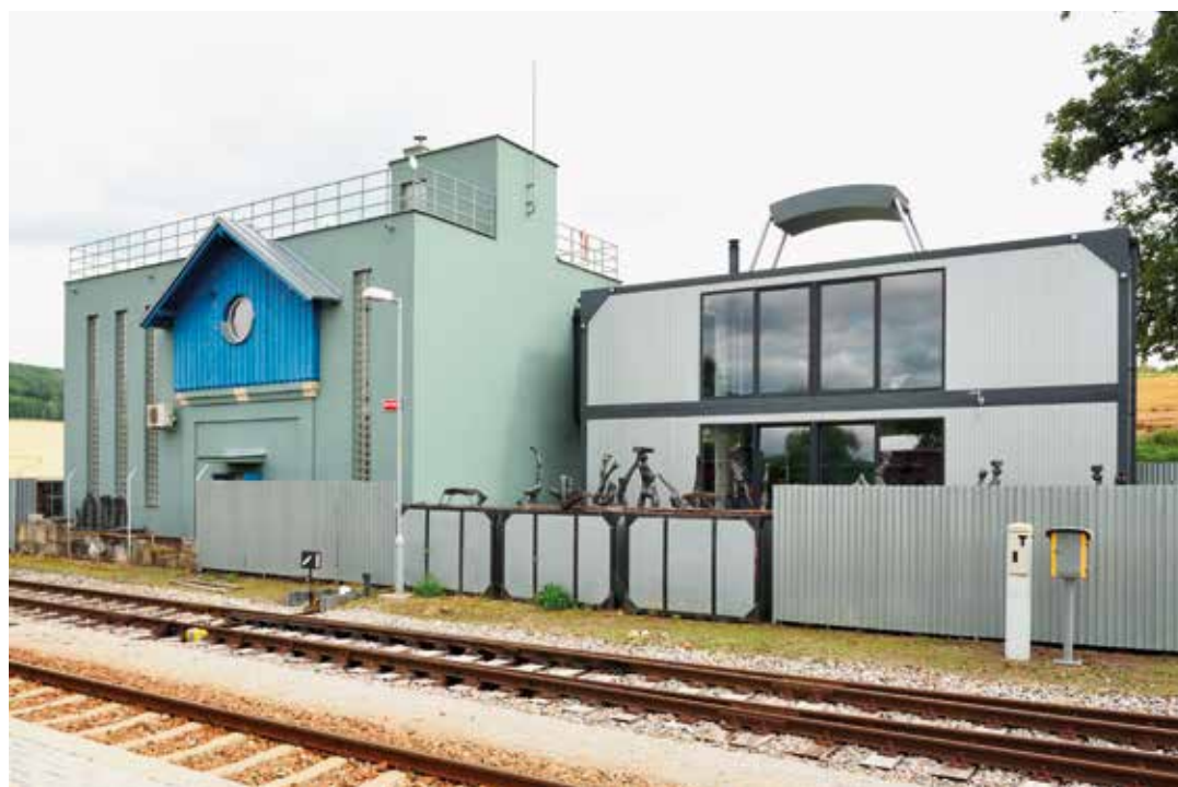
Obr. 7. Přestavba vodojemu v Kájově na ateliér
