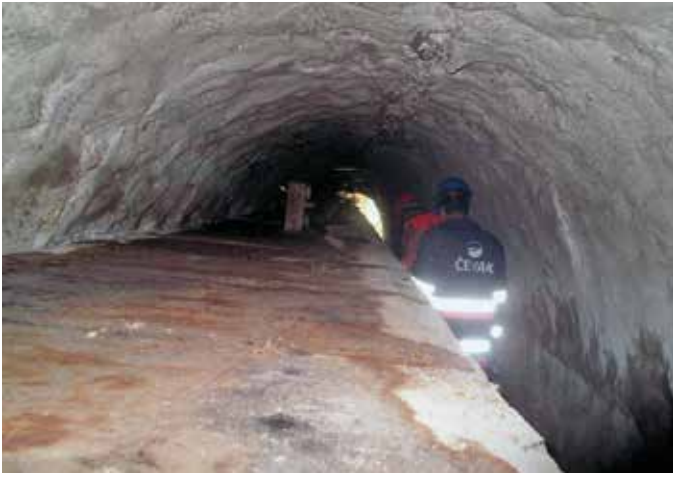
Obchvatný kanál – štola I – úsek před dolním výstupem
