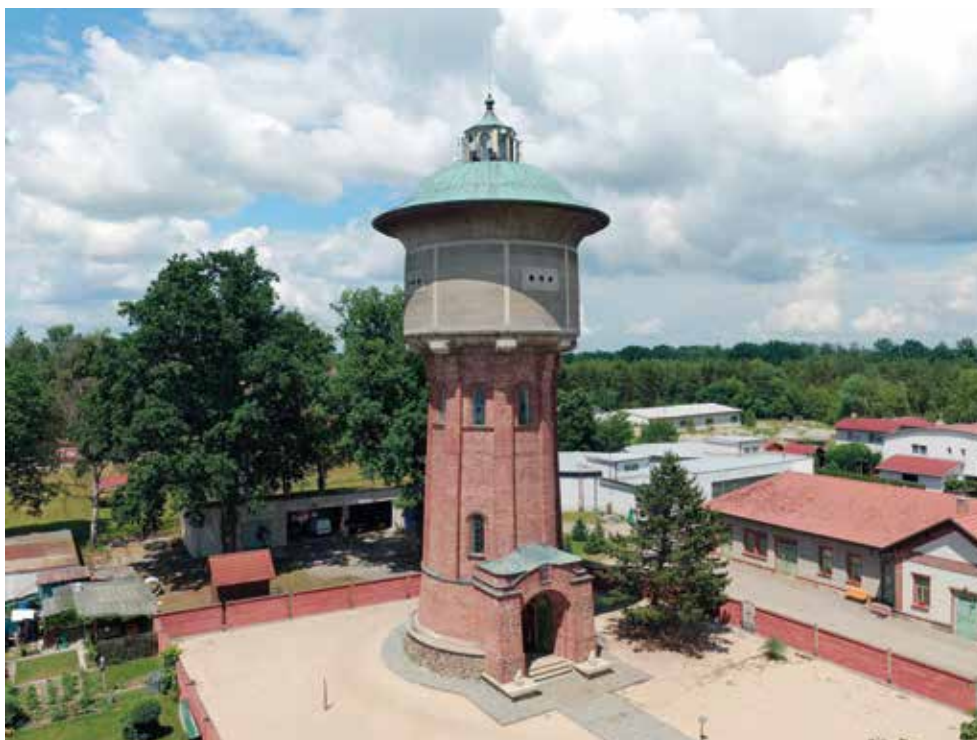
Obr. 1. Věžový vodojem v Třeboni
