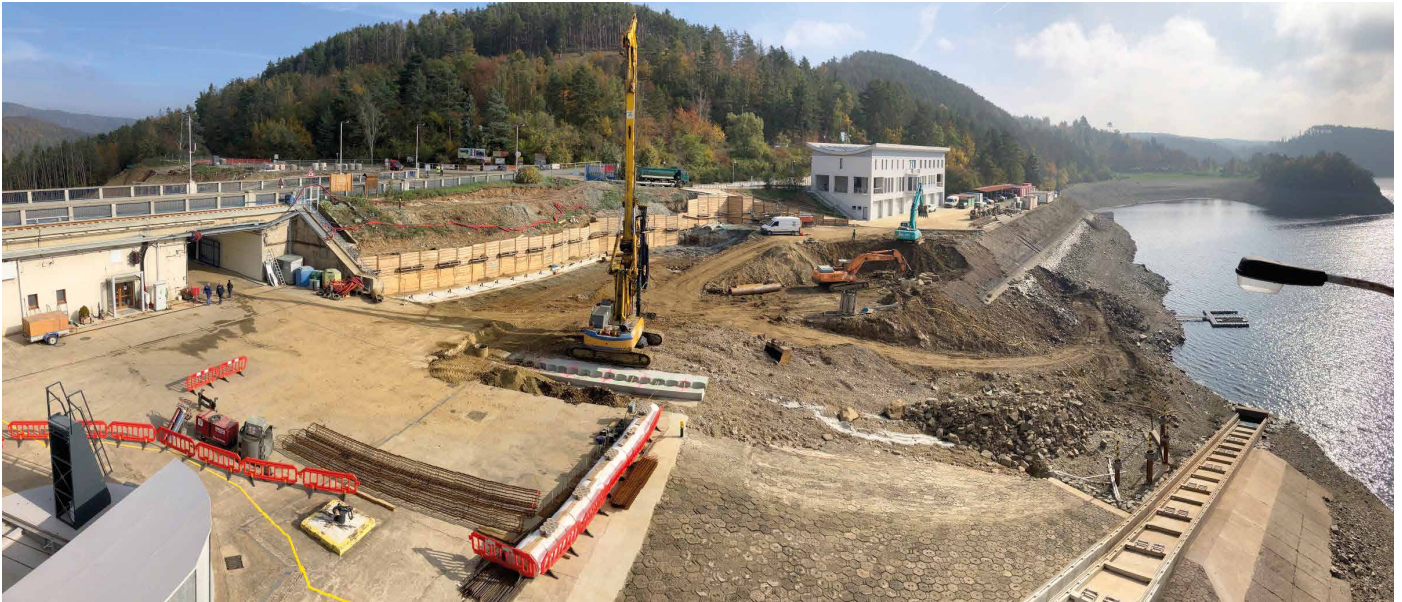
Obr. 11. Práce na novém přelivu – zakládání stavební jámy, 11. 10. 2022
