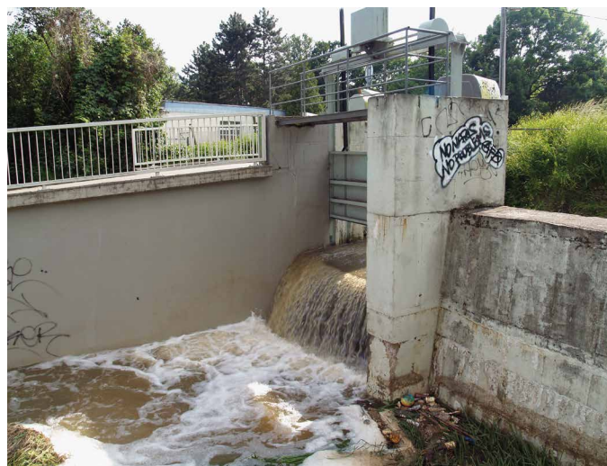
Obr. 1. Náпустný objekt historické zemní ochranné nádrže Brně-Řečkovice
