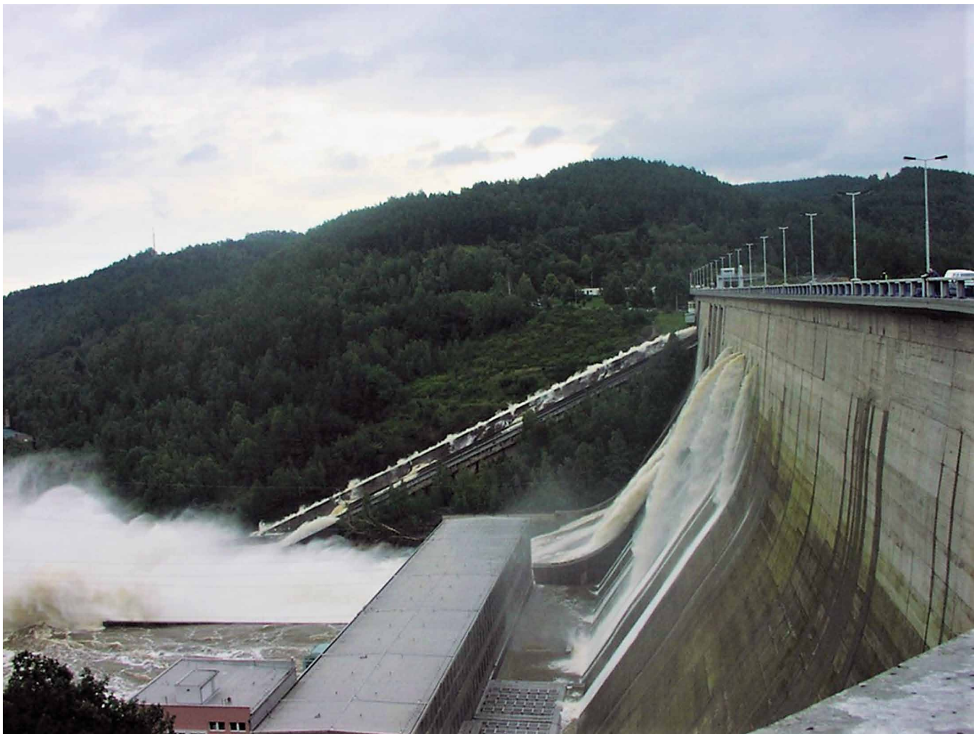
Obr. 2. Povodeň v srpnu 2002 – výtoky z větracích otvorů po zaplnění vnitřních prostor hráze
