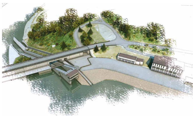
Obr. 4. Výchozí stav a varianta s novými přelivy mimo hráze se skluzem (viz [10])
