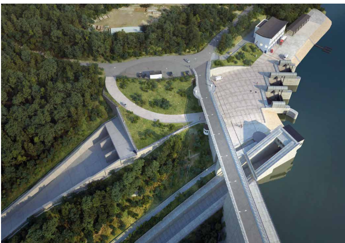
Obr. 7. Nový přeliv a skluz v prostoru pravého břehu na podkladu dokumentace pro provedení stavby (vizualizace AQUATIS a. s. – viz [14])
