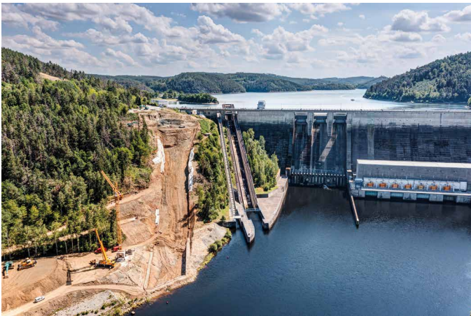
Obr. 12. Výlom skluzu, 28. 7. 2022
