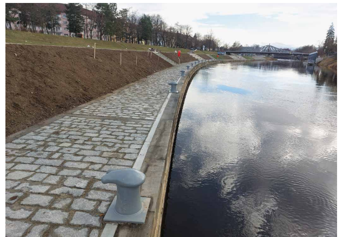
Obr. 4. Vyvazovací prvky na přístavní hraně – pacholata na přístavní hraně
