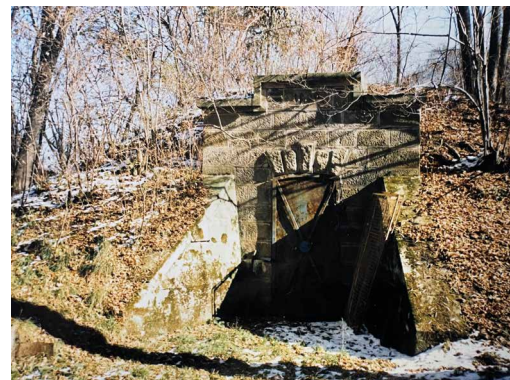
Obr. 7: Fotografie – vodojem Nedabyle, který 100 let sloužil k zásobování Českých Budějovic pitnou vodou v letech 1882 až 1981
