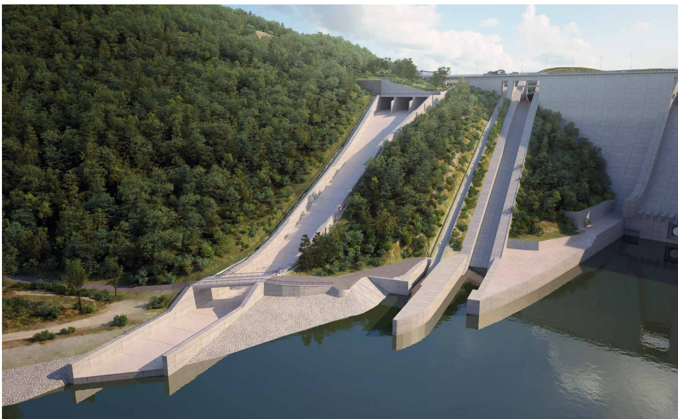
Obr. 6. Začlenění nového skluzu do prostoru pravého břehu dle DUR (vizualizace AQUATIS a. s.)
