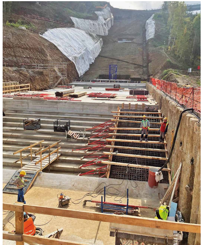
Obr. 13. Prostor připravený pro zkušební betonáž, 14. 9. 2022
