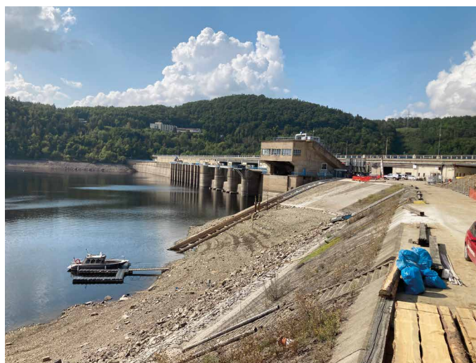
Obr. 10. Snížení hladiny na přehradě Orlik za účelem zahájení prací na novém přelivu, 25. 8. 2022
