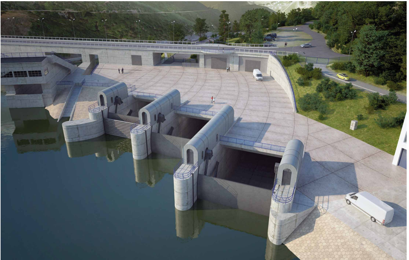
Obr. 7. Nový přeliv a skluz v prostoru pravého břehu na podkladu dokumentace pro provedení stavby (vizualizace AQUATIS a. s. – viz [14])
