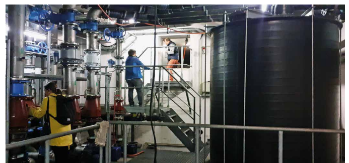
Obr. 7. Technologie a podzemní nádrže, Postdamer Platz, Berlín
