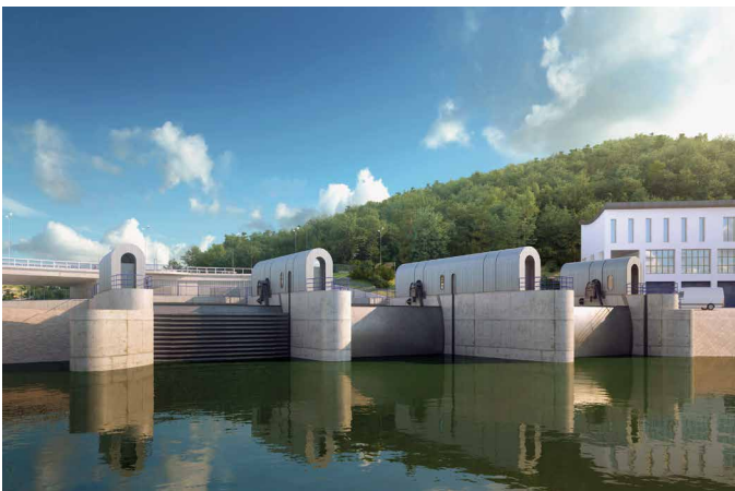
Obr. 8. Začlenění přelivu a skluzu do prostoru pravého břehu (vizualizace AQUATIS a.s. viz [14])
